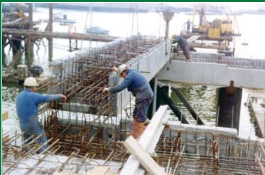
Construction de l'élevateur : une structure imposante soutenue par d'énormes tubes remplis de béton enfoncés à moins cinq mètres des plus basses mers. Document SECMAR.
