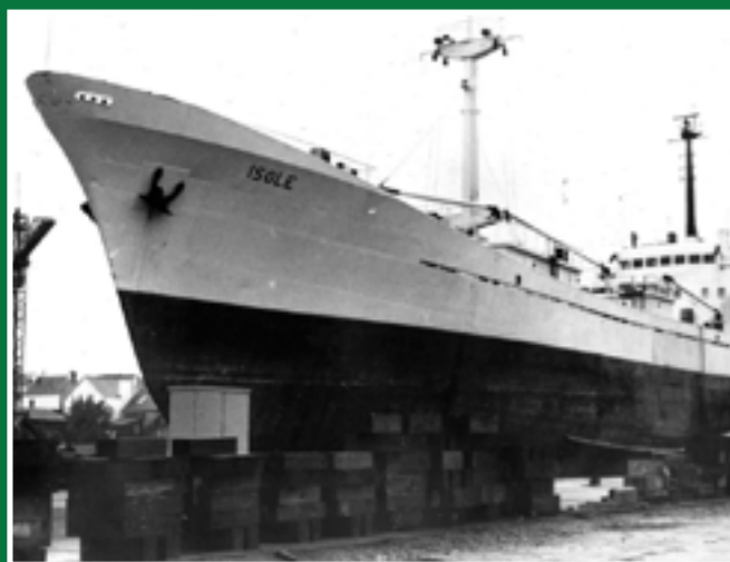
L'Isolé, un cargo de la COBRECAF monté pendant les essais, permet aux ingénieurs de la société Paris de mieux adapter les six paires de vérins à crémaillères.
