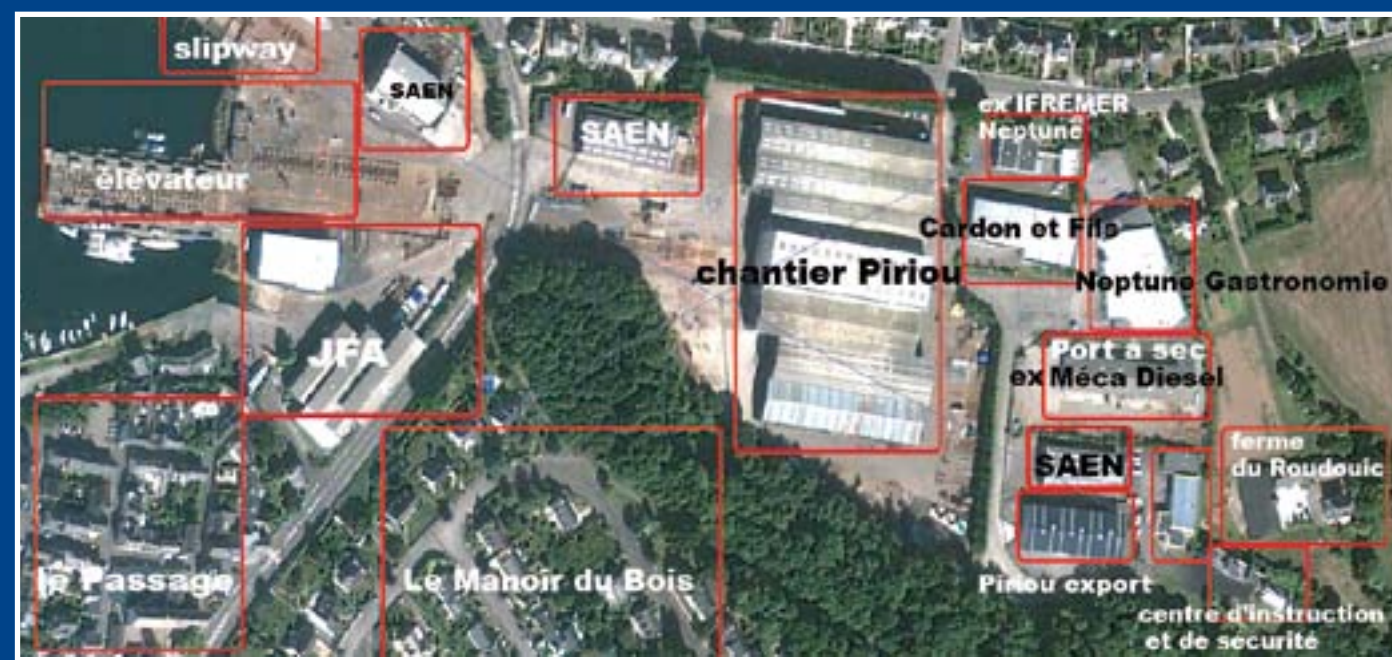
A gauche de l'élevateur, les ateliers de JFA - plaisance , de part et d'autre de la route, la SAEN , peinture-marine, au centre, les ateliers du chantier Piriou , à l'arrière, l'entreprise Neptune gastronomie et son extension, ex-IFREMER ainsi que les ateliers de Cardon j et fils (SA équip marine), l'ex-atelier de Meca Diesel devenu aujourd'hui une zone de stockage du port-à-sec , en bas, Piriou export et le centre d'instruction et de sécurité pour la lutte contre les incendies à bord des navires géré par le Centre Européen de Formation Continue Maritime. le CEFCM ex-école de pêche.
