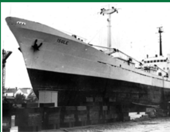
L'Isolé, un cargo de la COBRECAF monté pendant les essais, permet aux ingénieurs de la société Paris de mieux adapter les six paires de vérins à crémaillères.
