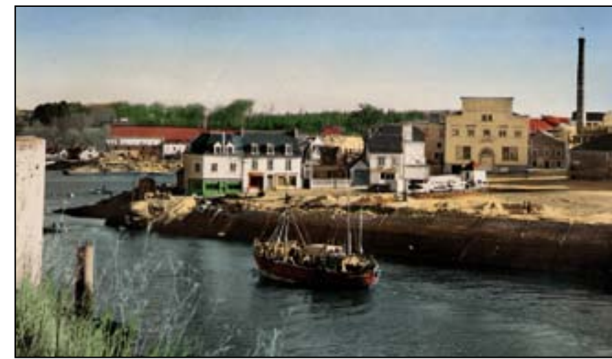
Construction du perré au Passage en 1953
